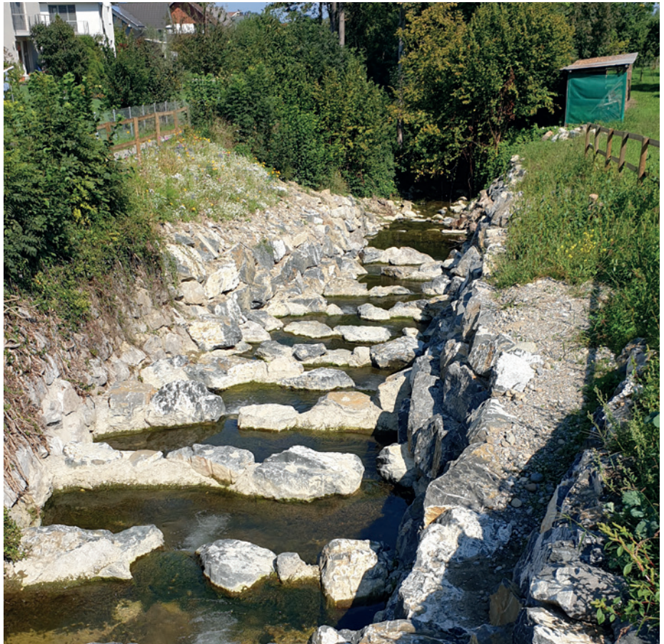
Der Hornbach mit der neuen Fischtreppe
