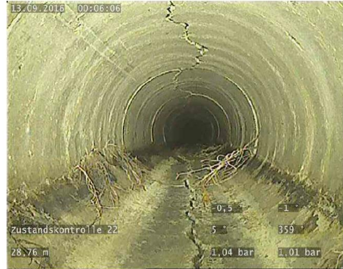
17, 12:06:06, 28.76 Komplexes Wurzelwerk von 4 Uhr bis 8 Uhr, 10% Querschnittsverminderung, Start
