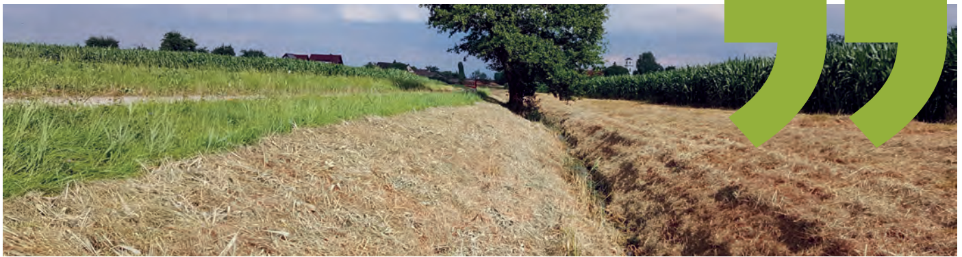
Der Geusenbach zwischen Altnau und Güttingen
