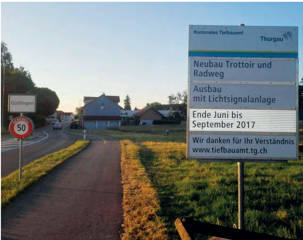
Bauarbeiten zugunsten von mehr Sicherheit für Fussgänger und Fahrradfahrer an Altnauerstrasse.
