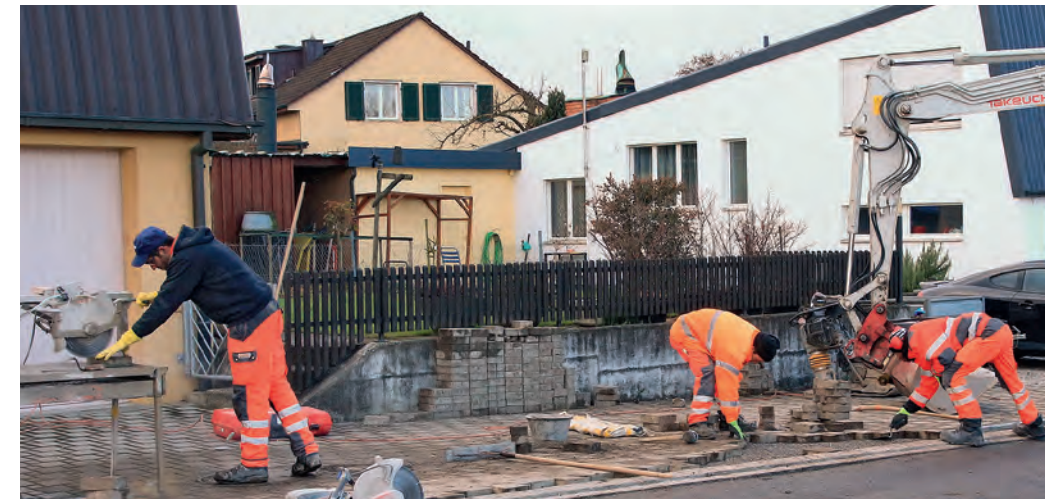
Die Arbeiten an der östlichen Strassenseite wurden im Dezember abgeschlossen.
